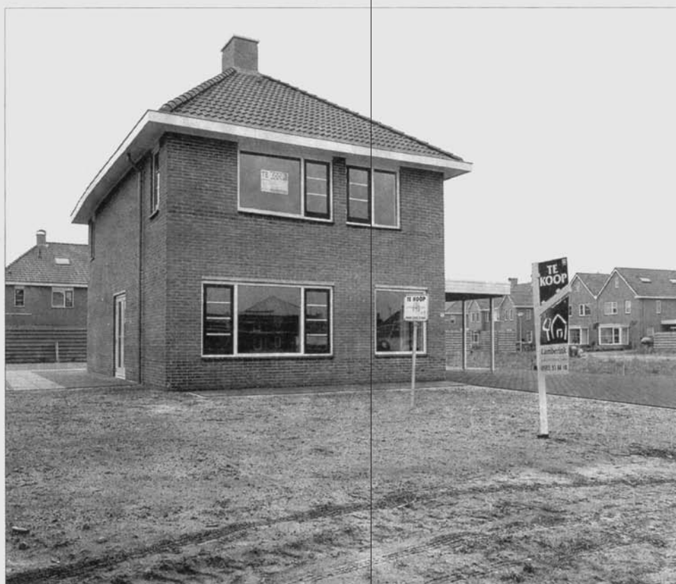
Nieuwbouw in Assen.
